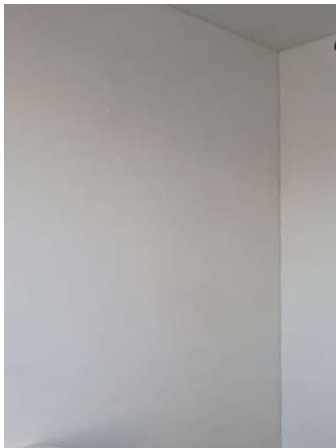
Wand afwerking Wit Mat
